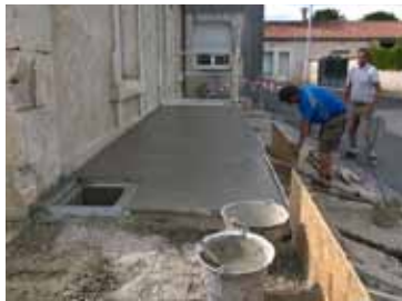
Salle de la Petite Fouillère : mise en accessibilité P.M.R
