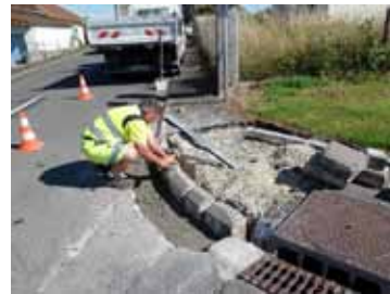
Voirie : pose de bordures par les services techniques
