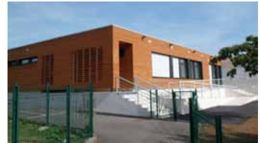
Ecole élémentaire : réhabilitation
