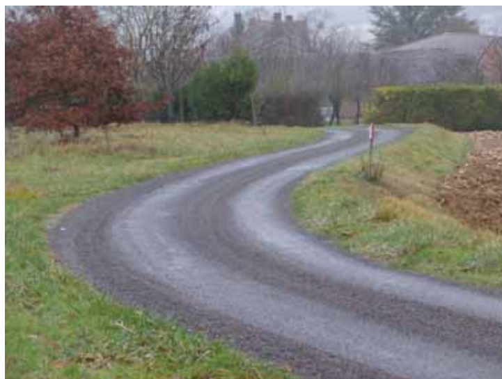
Chemin rural de Pierre Levée à Chevanon : réfection de la chaussée
