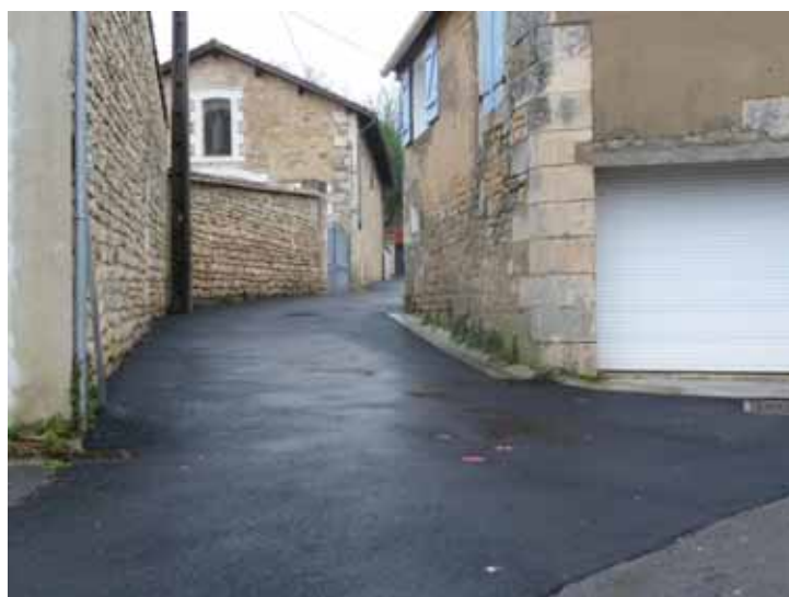
La Touche chemin de la Fontaine : réfection de la chaussée
